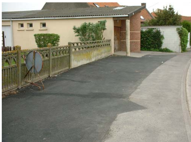
Abattage des peupliers et remise en état du parking de l'école Daudet-Perrault
