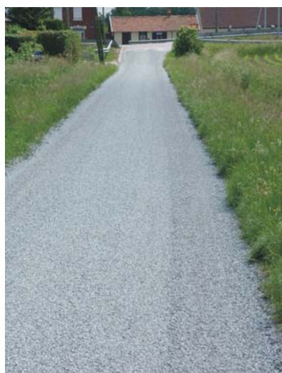
Remise en forme de la rue Léon Duriez avant et après gravillonnage
