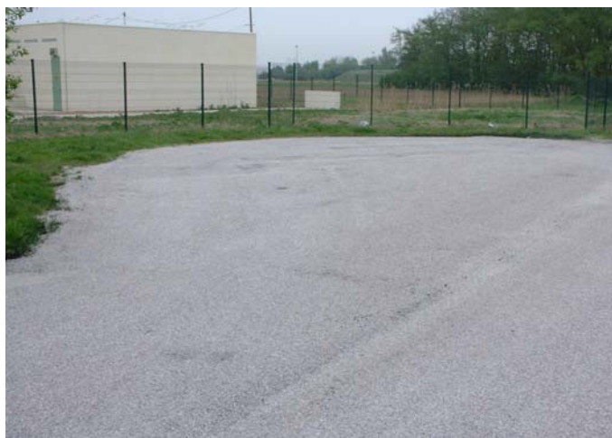
Remise en état d'une partie de la route et du rond-point rue Louis Lemaire
